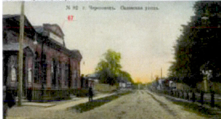
9 г. Череповец. Садовая улица. Фото до 1917 года из набора открыток. Вид на современную ул. Милютина. В левой части фото расположен дом №7 по ул. Милютина. Источник: ЧерМО, № 049
