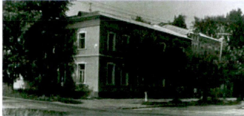
14 г. Череповец. Советский проспект дом № 15. Фото сер. XX в. Источник: Паспорт объекта культурного наследия
