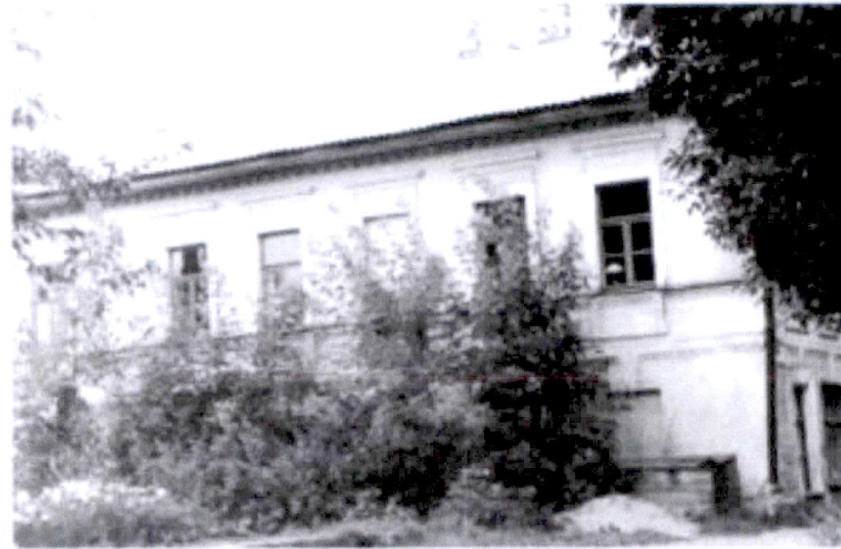
19 Дом жилой с магазином Демидова С. А. по адресу Советский проспект дом №28. Западный фасад. Фото 1981 г. Источник: Паспорт объекта культурного наследия
