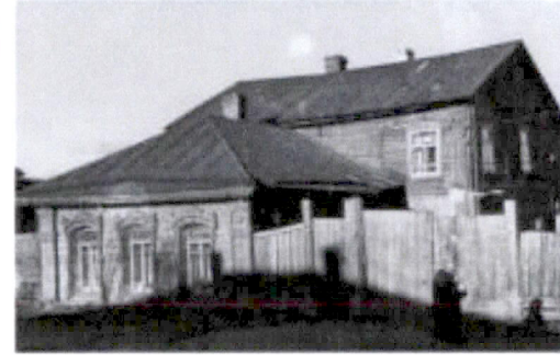
10 Ефимовский Г. И. Череповец. Жилой дом по улице Труда дом №54. Фото 1959 года. Источник: http://www.shot.su/imagetour/sherovets_na_ankovetke_luftwaffe_1942_d_senb
