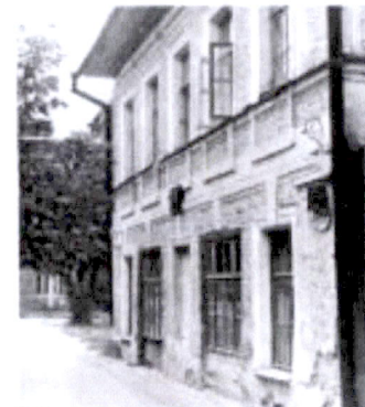
20 Дом жилой с магазином Демидова С. А. по адресу Советский проспект дом №28. Западный фасад. Фото 1981 г. Источник: Паспорт объекта культурного наследия
