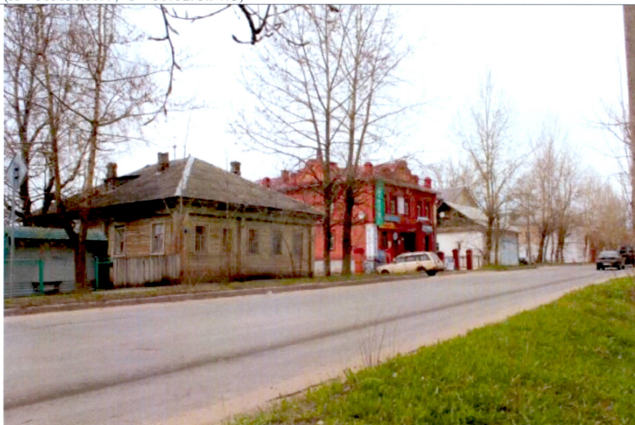
Точка Т26 Общий вид улицы Ленина от дома № 67 в сторону центральной площади (бывшей Соборной площади) (X = 315038.1099; Y = 3175295.9473)
