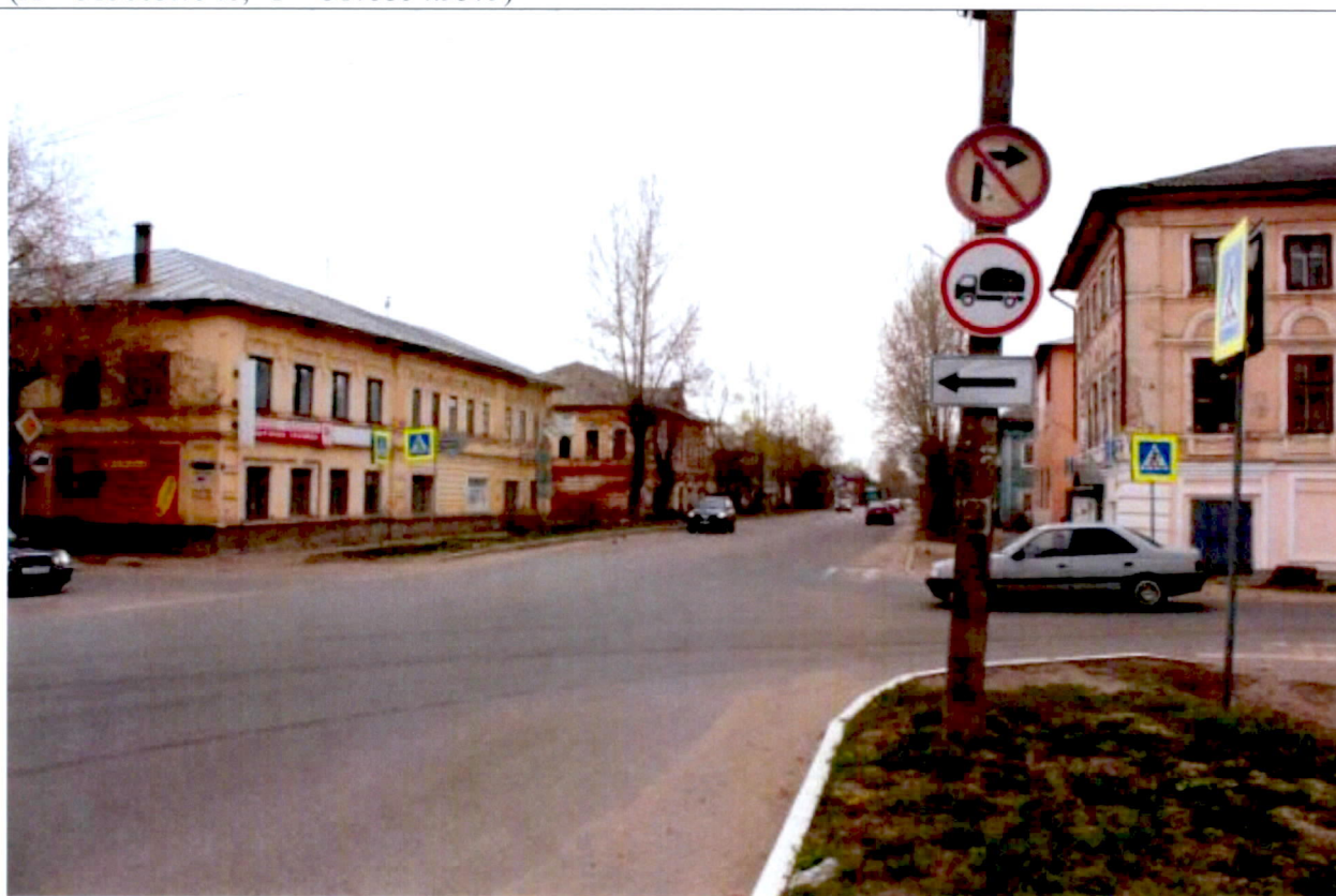
Точка Т 20 Вид на застройку улицы Ленина от дома № 39 по ул. Ленина в северном направлении (X = 315605.7540; Y = 3175354.9579)
