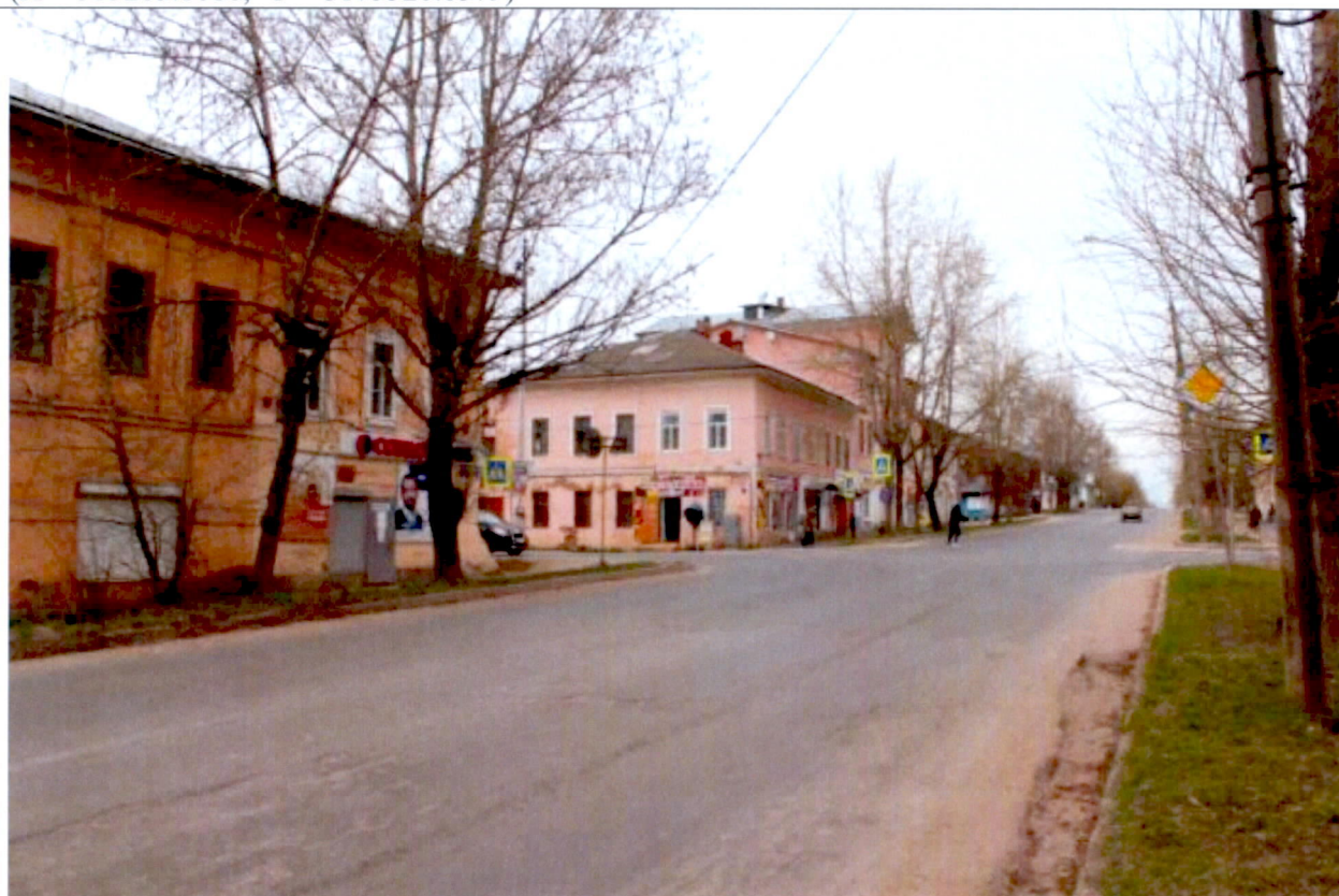
Точка Т24 Общий вид улицы Ленина от дома № 53 в сторону центральной площади (бывшей Соборной площади) (X = 315285.1688; Y = 3175320.6379)
