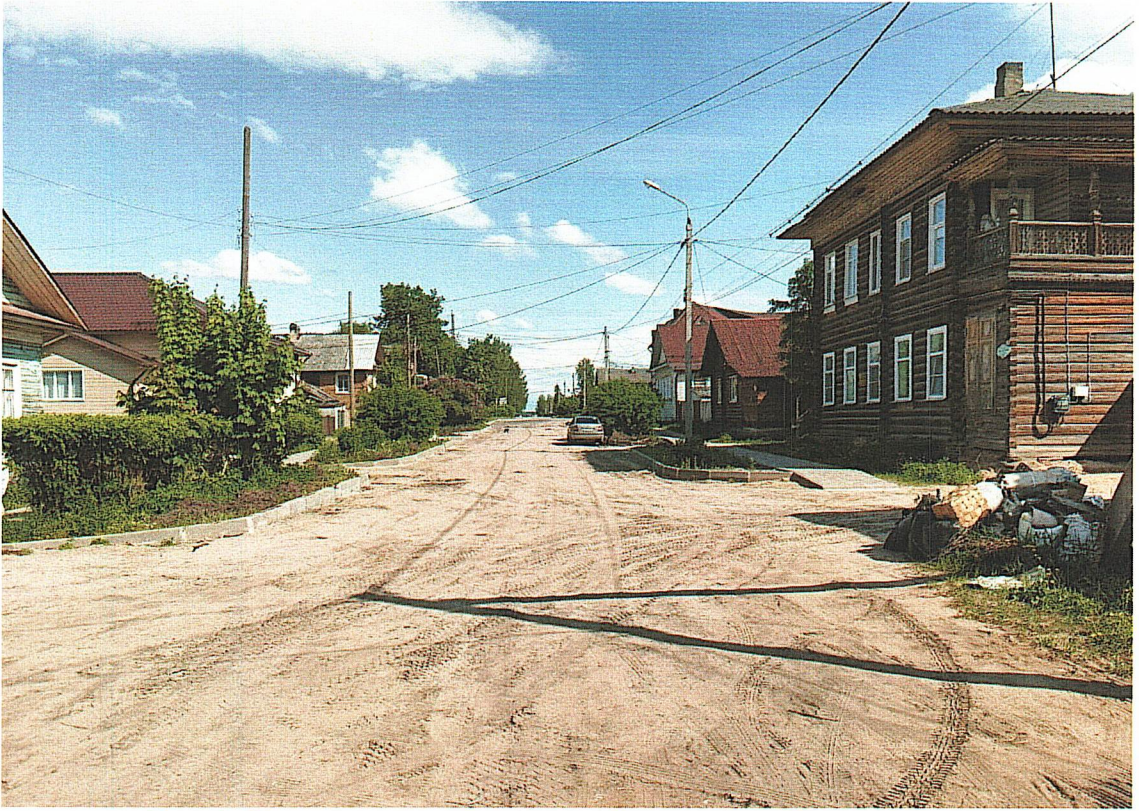
Рис. 8. Видовое раскрытие по ул. Карпеченко. Вид на восток. Слева расположен объект культурного наследия регионального значения «Дом Шеловановой».
