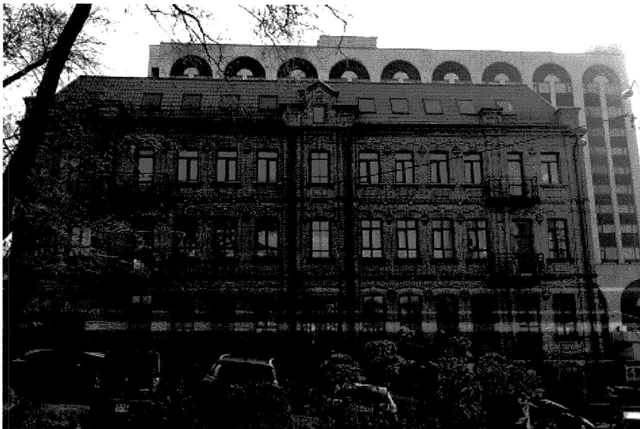
Архитектурная композиция фасада симметрична. По горизонтали сформирована лопatkами, раскреповкой в центральной части и равномерным размещением оконных и балконных проемов, по вертикали - профилированными междуэтажными поясками, венчающим карнизом.
