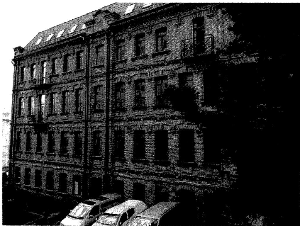
Архитектурная композиция фасада преимущественно симметрична, легкий сбитый ритм задан, за счет неравного количества световых осей восточной и западной сторон, относительно оси. По горизонтали сформирована лопатками, равномерным размещением оконных и балконных проемов, по вертикали - профилированными междуэтажными поясками, венчающим карнизом.
