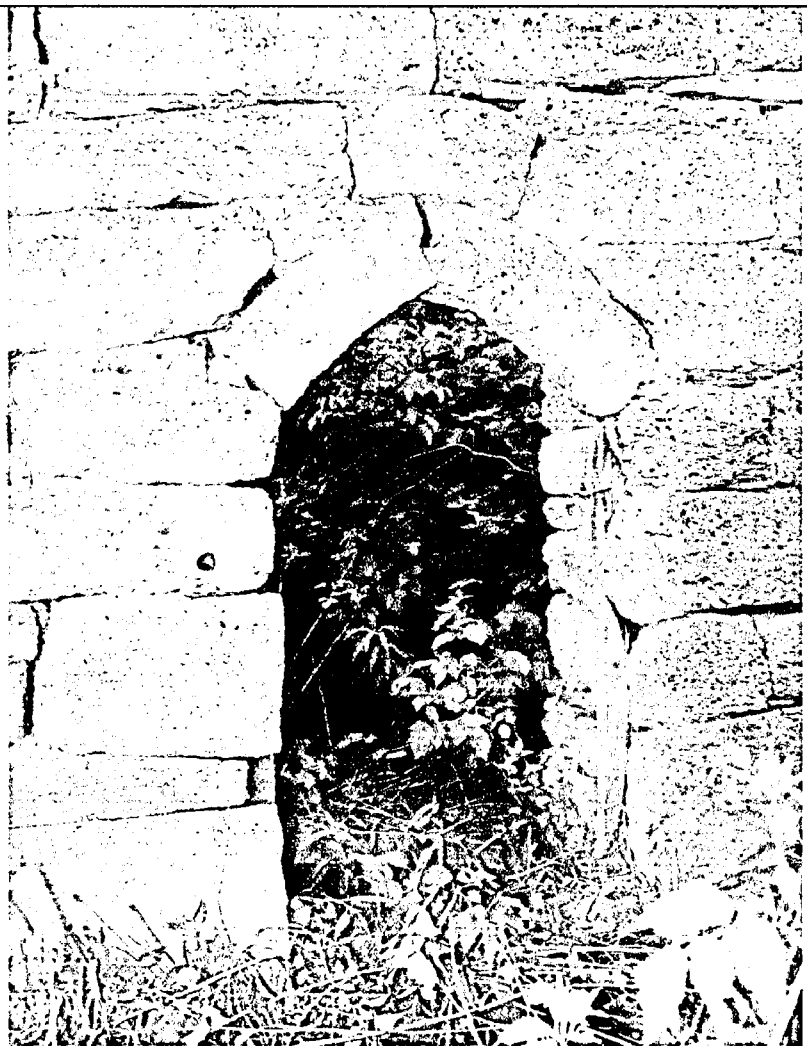
Входной проем. Вид снаружи.
