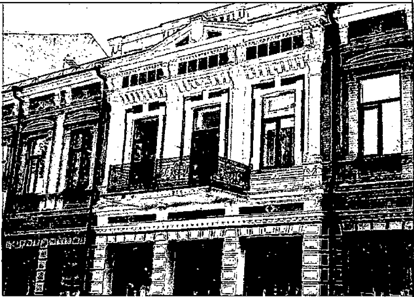
1.14. Металлические решетки ограждения балконов по фронту западного и южного фасадов
