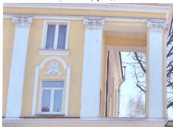
Прямоугольные пилястры северо-восточного (главного) фасада.
