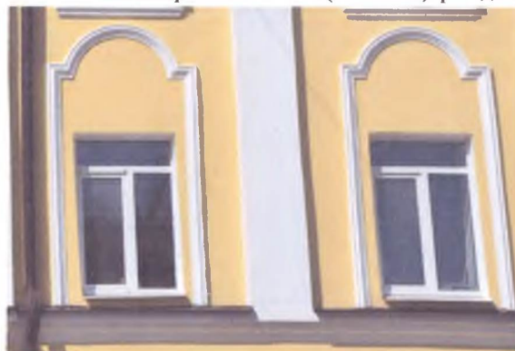
Обрамления оконных проемов 2-го этажа юго-восточного (бокового) фасада.
