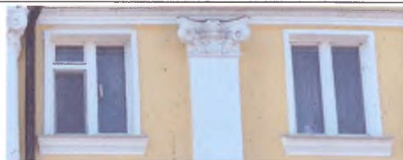
Обрамления оконных проемов 3-го этажа северо-восточного (главного) фасада.
