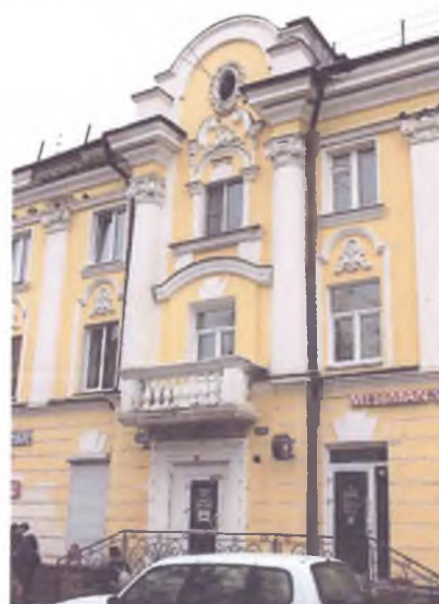
Фрагмент северо-восточного (главного) фасада, ризалит.
