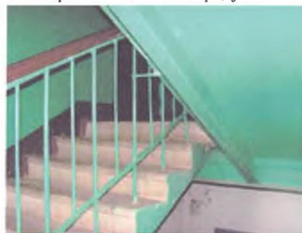
Фрагмент лестничной клетки.
