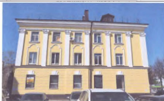
Юго-восточный (боковой) фасад объекта.
