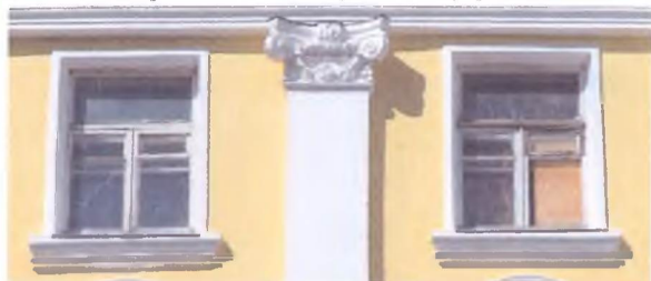
Обрамления оконных проемов 3-го этажа юго-восточного (бокового) фасада.
