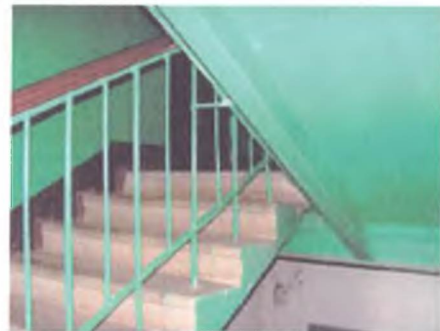
Фрагмент лестничной клетки.
