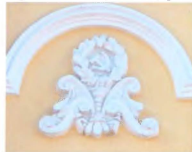
Лепная композиция обрамления оконного проема 2-го этажа северо-восточного (главного) фасада.
