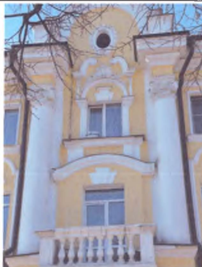
Полукруглые пилястры северо-восточного (главного) фасада.
