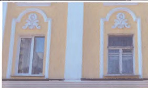
Обрамления оконных проемов 2-го этажа северо-восточного (главного) фасада.
