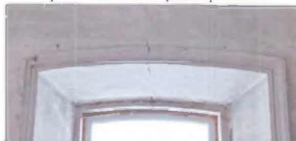
Фрагмент оконного проема южного крыла притвора.
