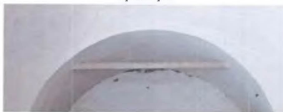
Фрагмент арочного проема (ниши) южного крыла притвора.
