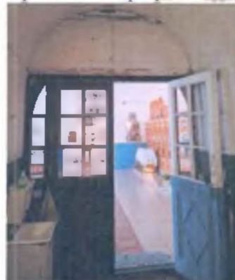
Фрагмент интерьера притвора.
