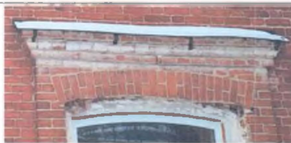
Фрагмент оконного проема трапезной.
