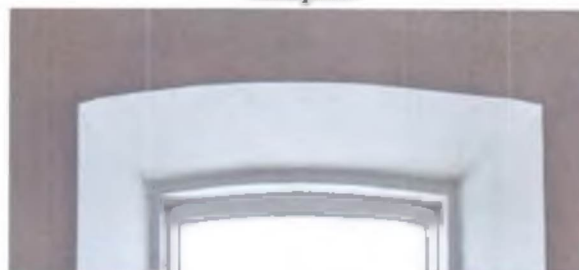
Фрагмент оконного проема трапезной.
