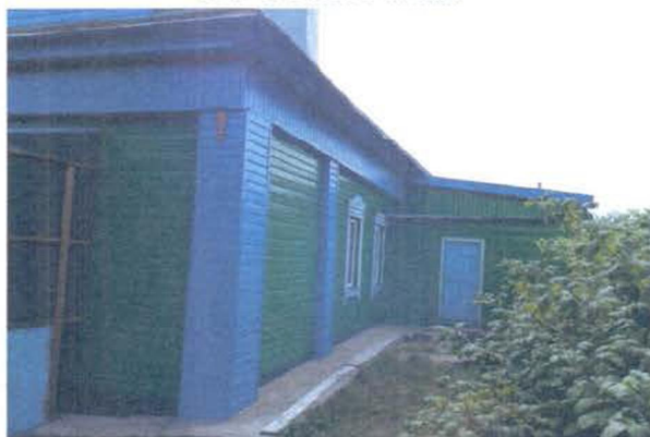
Фрагмент западного фасада (вид с северо-запада)
