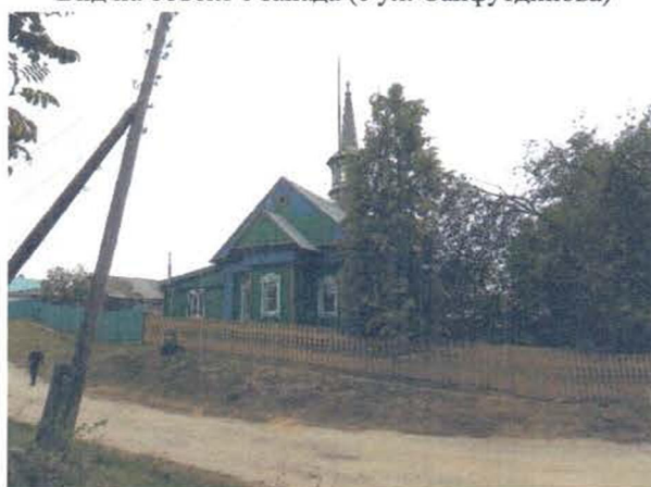
Вид на объект с юго-востока (с ул. Сайфутдинова)
