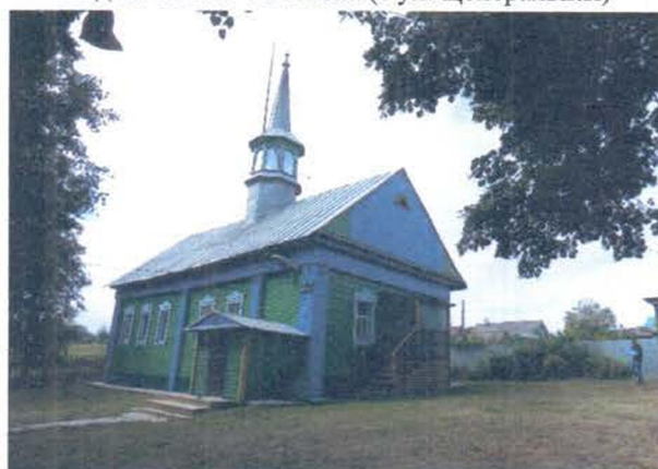
Вид на объект с северо-востока (с территории объекта)
