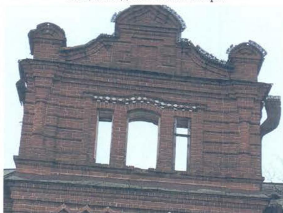
Фрагмент северо-восточного фасада.
