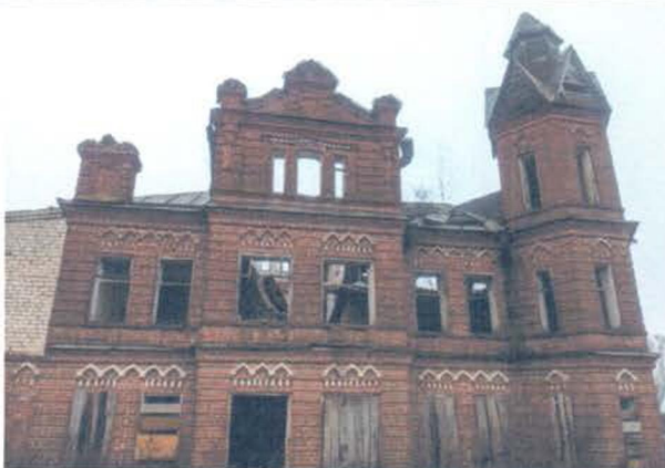
Главный уличный (северо-восточный) фасад.
