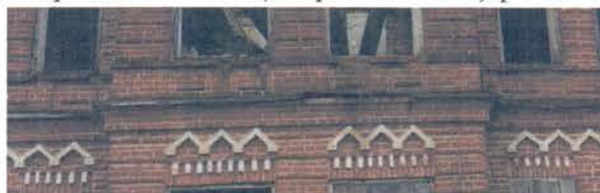
Фрагмент главного (северо-восточного) фасада.
