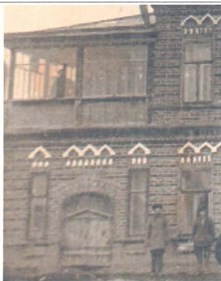
Историческое фото, фрагмент главного уличного (северо-восточного) фасада.
