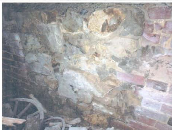
Фрагмент интерьера подвала.
