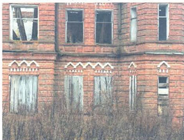
Фрагмент главного (северо-восточного) фасада, оконные проемы 1-го-2-го этажей.
