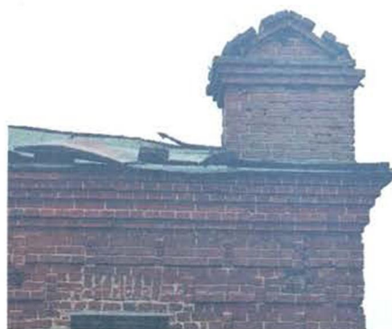
Фрагмент бокового уличного (северо-западного) фасада, парапетный столбик.
