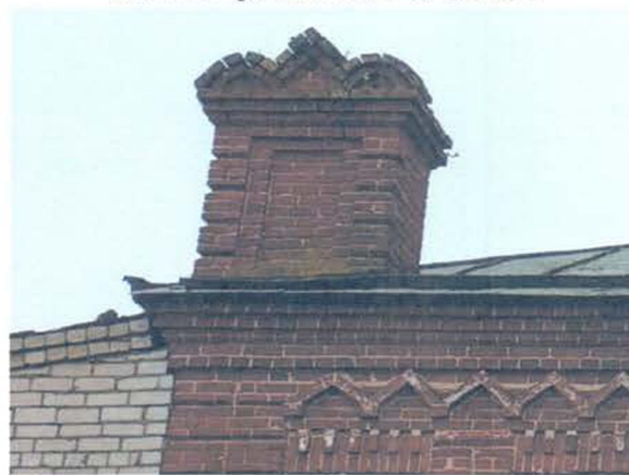
Фрагмент главного (северо-восточного) фасада.
