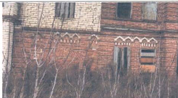
Фрагмент главного (северо-восточного) фасада.
