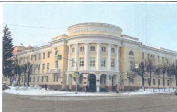
Вид на объект с перекрестка Ленинского проспекта и проспекта Гагарина.
