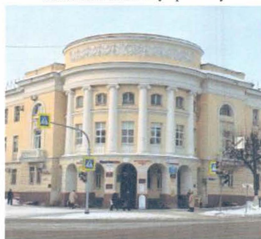
Фрагмент уличного фасада (вид с перекрестка Ленинского проспекта и проспекта Гагарина).
