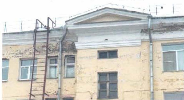
Фрагмент дворового фасада.
