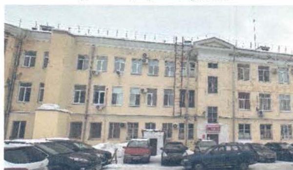
Фрагмент дворового фасада.
