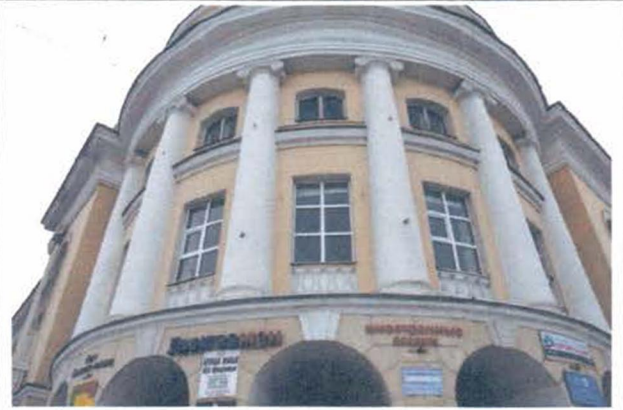
Фрагмент уличного фасада (вид с перекрестка Ленинского проспекта и проспекта Гагарина).
