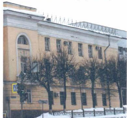
Фасад по Ленинскому проспекту.
