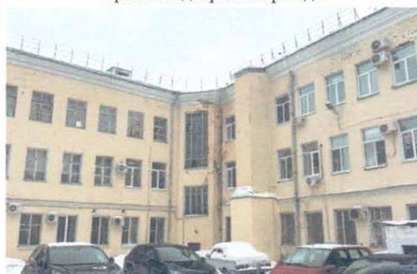
Фрагмент дворового фасада.
