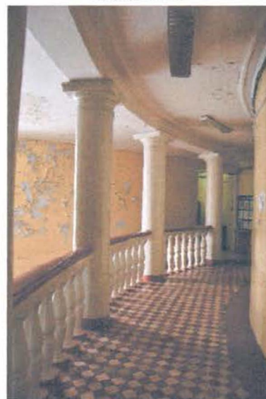
Фрагмент интерьера 3-го этажа.
