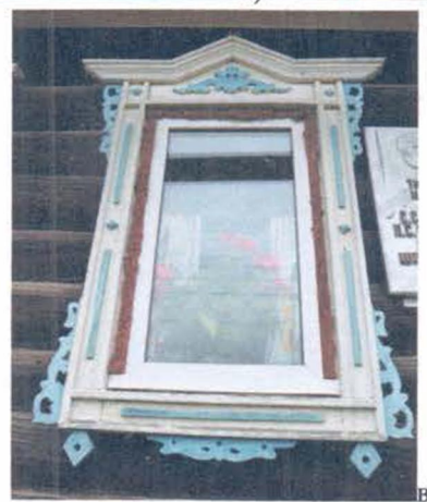
Окна: а) фрагмент южного фасада; б) фрагмент северного фасада; в) фрагмент восточного фасада.
