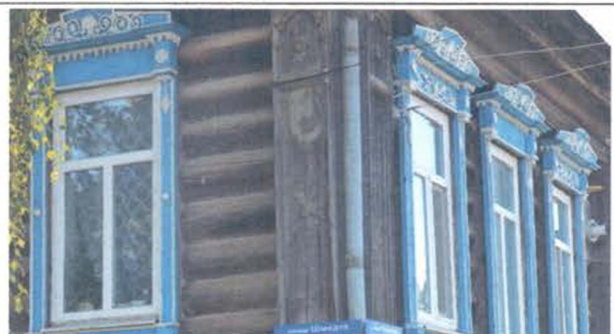
Фрагмент уличного фасада (вид с севера). Фото 2022 г.
