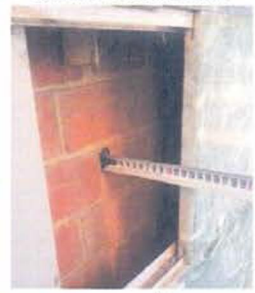
Фрагмент западного фасада, вскрытие вентилируемого фасада. Фото 2023 г.
