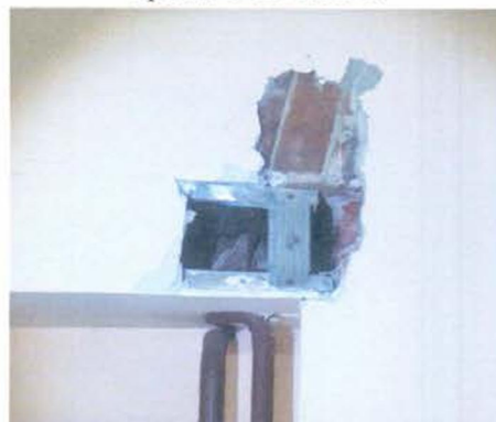
Фрагмент интерьера, вскрытие окрасочного и штукатурного слоев над заложенным дверным проёмом. Фото 2023 г.
