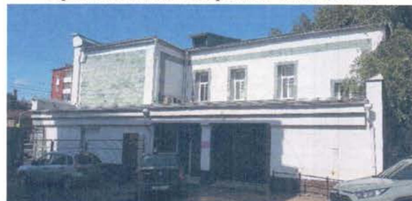
Общий вид объекта с востока. Фото 2023 г.
