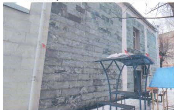
Северный фасад объекта. Фото 2023 г.
