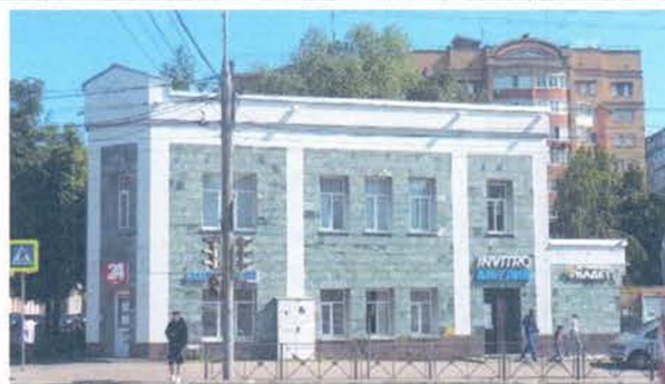
Общий вид объекта с юга. Фото 2023 г.
