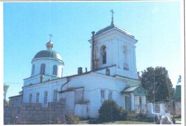
Общий вид объекта с запада.
