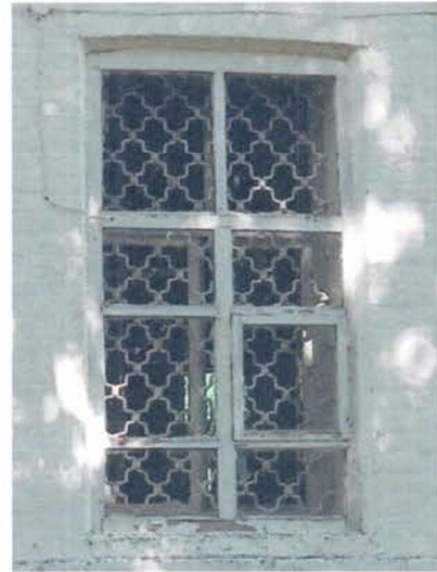
Фрагмент юго-восточного фасада, окно трапезной.
