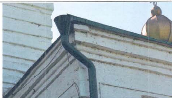
Фрагмент (вид с юга), венчающий карниз трапезной.
