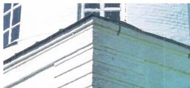
Фрагмент (вид с востока), карниз 2-го света четверика.
