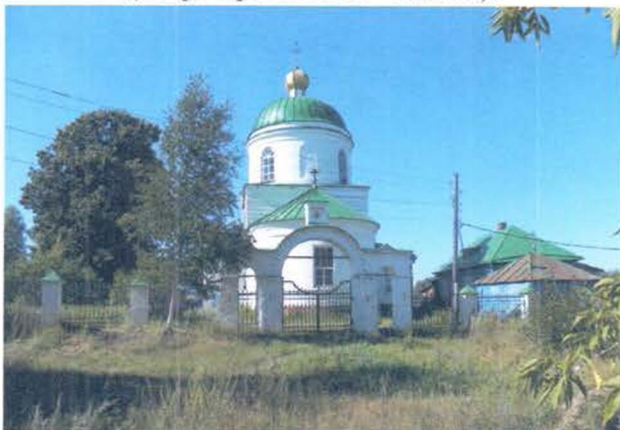
Вид на объект с северо-востока.
