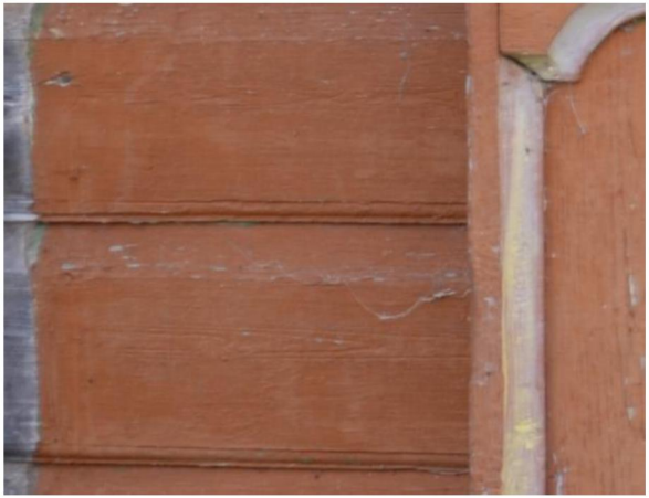
Фрагмент главного фасада. Фото 2022 г.
