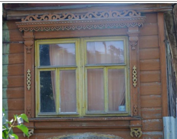
Фрагмент главного фасада, окно 2-го этажа пристроя.
