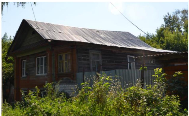
Общий вид объекта с севера. Фото 2022 г.
