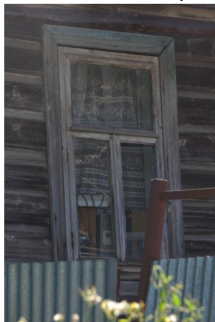
Фрагмент бокового (северо-западного) фасада, окно 2-го этажа.
