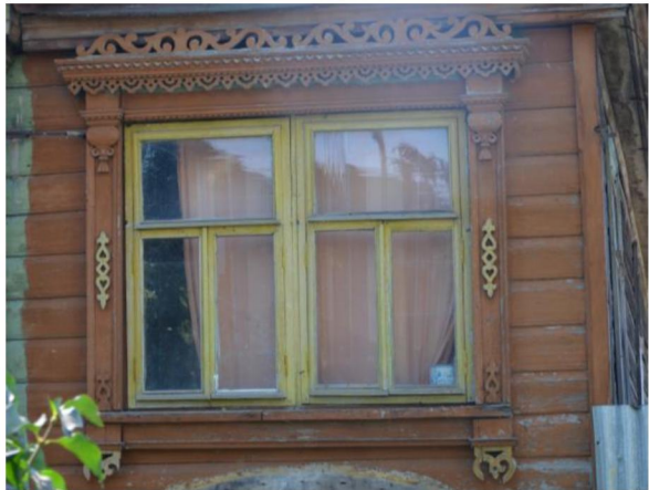
Фрагмент главного фасада. Фото 2022 г.
