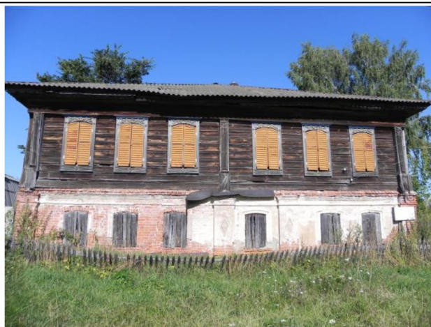
Главный фасад объекта.
