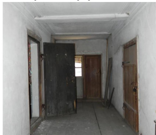
Фрагмент интерьера 2-го этажа.
