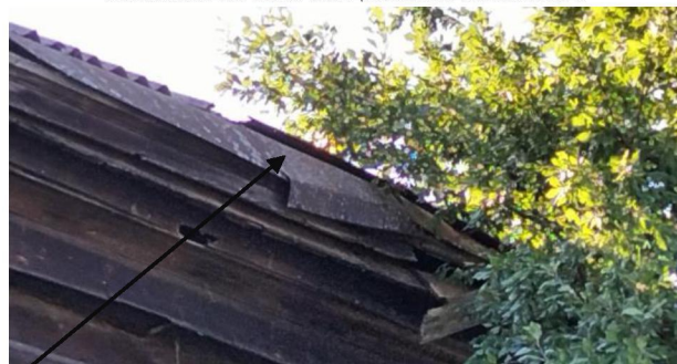
Фрагмент северо-восточного фасада. Историческое покрытие кровли из кровельного листового металла, на который положено позднее покрытие из волнистых асбестоцементных листов.
