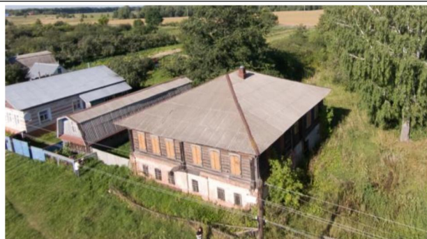
Общий вид объекта сверху.
