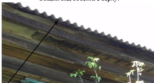
Фрагмент юго-восточного фасада. Историческое покрытие кровли из кровельного листового металла, на который положено позднее покрытие из волнистых асбестоцементных листов.
