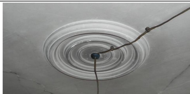
Фрагмент интерьера 2-го этажа.
