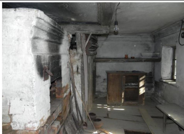
Фрагмент интерьера 1-го этажа.
