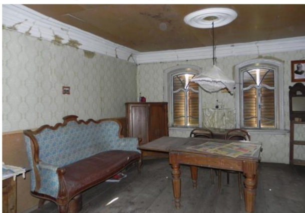
Фрагмент интерьера 2-го этажа.
