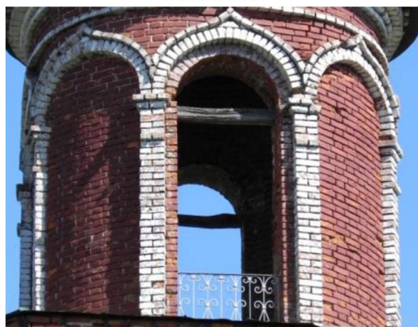
Фрагмент южного фасада проем 3-го яруса колокольни.
