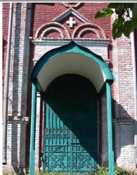
Фрагмент южного фасада.
