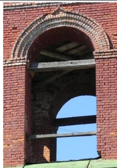
Фрагмент южного фасада, проем 2-го яруса колокольни.
