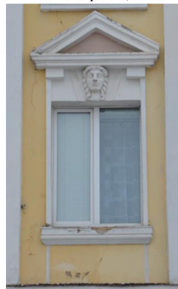
Фрагмент главного фасада, окно 3-го этажа.
