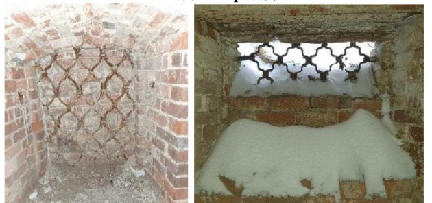
Оконные проемы подвальных помещений.
