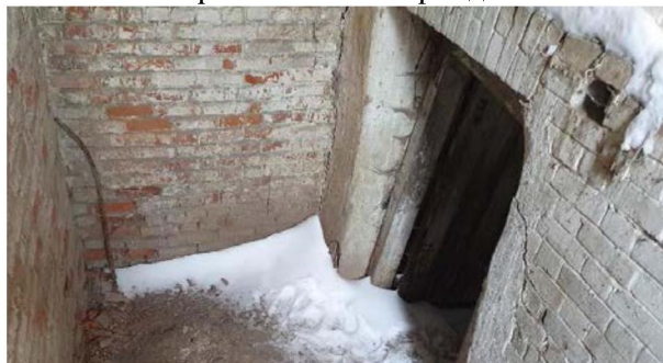
Фрагмент интерьера пристроя (вход в подвал).
