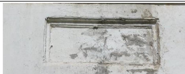
Фрагмент южного фасада.
