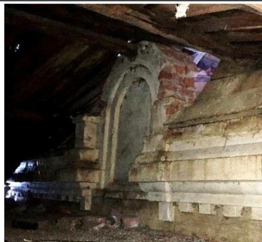
Ложная закомара по северному фасаду четверика в объеме крыши притвора.
