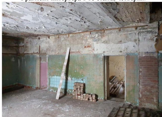
Фрагмент интерьера 1-го этажа, притвор.
