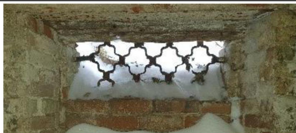
Окно подвального помещения с подлинной кованной решеткой
