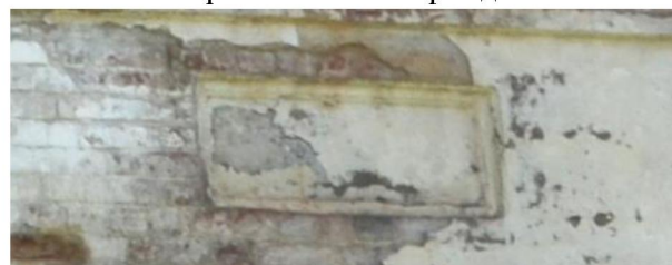
Фрагмент западного фасада.
