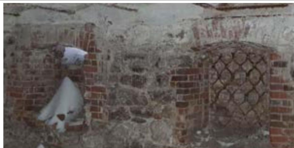
Фрагмент интерьера (подвал).
