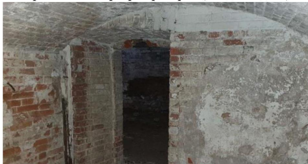
Фрагмент интерьера (подвал).
