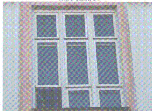
Фрагмент фасада по ул. Палантая, одинарное окно типа 6.
