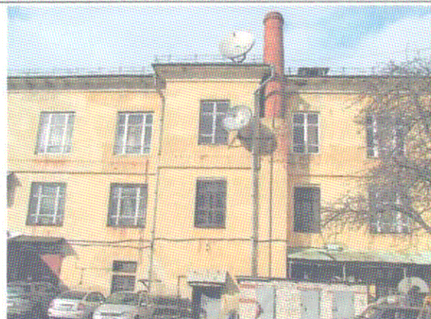
Фрагмент дворового фасада (вид с юго-запада).
