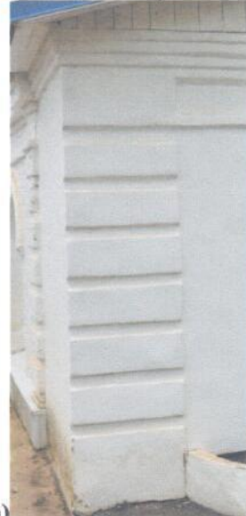
Фрагменты западного фасада: а) угловая лопатка 1-го яруса колокольни; б) лопатка паперти.
