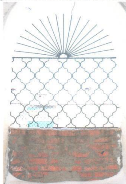
Фрагмент интерьера 3-го яруса колокольни, проем звона.
