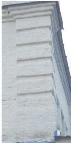
Фрагменты западного фасада: а) угловая лопатка 1-го яруса колокольни; б) лопатка паперти.
