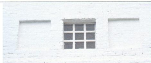
Фрагмент северного фасада, окно 1-го яруса колокольни.
