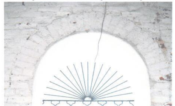
Фрагмент проем 3-го яруса колокольни.
