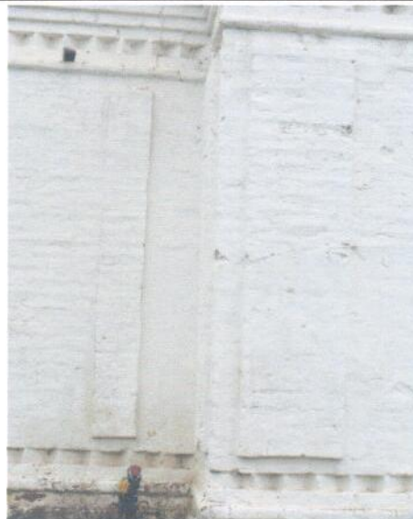
Фрагмент северного фасада.
