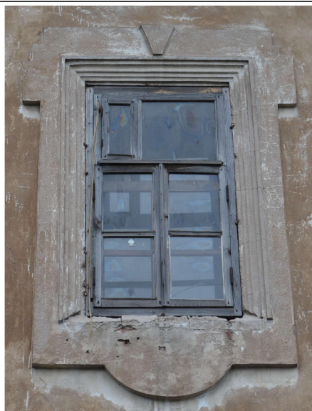
Фрагмент северного фасада
