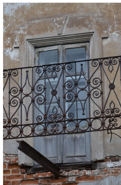
Фрагмент северного фасада
