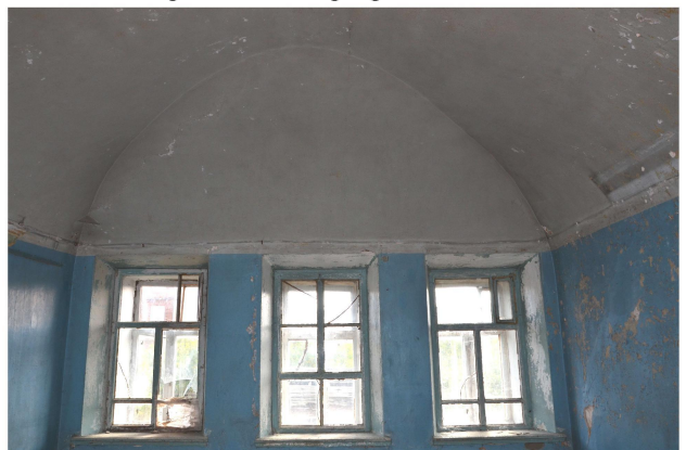
Фрагмент интерьера 2-го этажа
