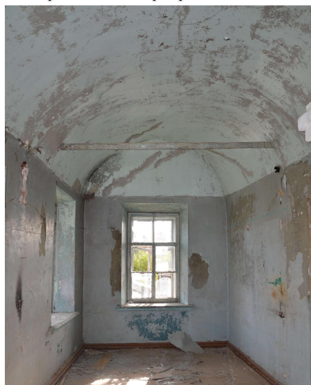
Фрагмент интерьера 2-го этажа
