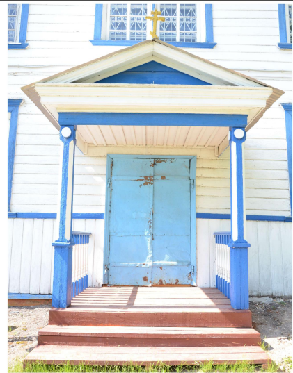
Фрагмент южного фасада
