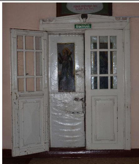
Фрагмент интерьера трапезной
