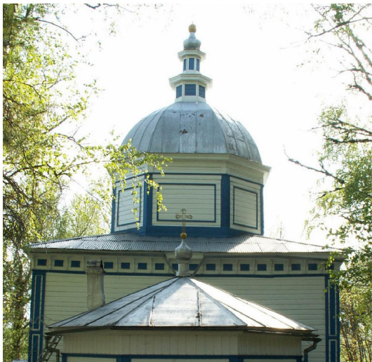
Фрагмент восточного фасада
