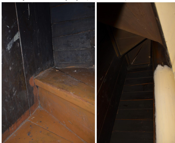
Фрагменты интерьера (четверик): фрагменты лестницы на клирос
