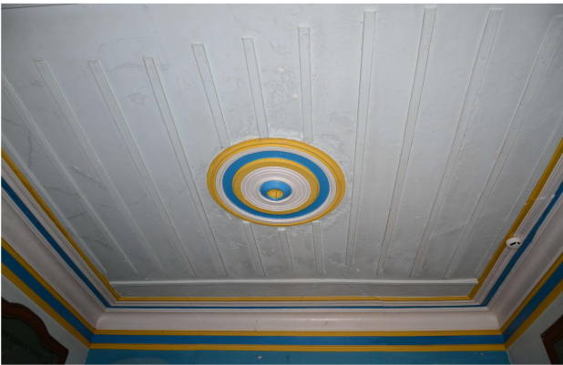
Фрагмент интерьера притвора
