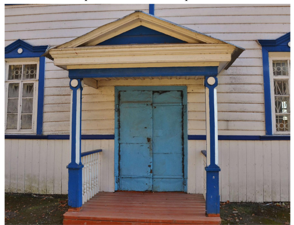
Фрагмент северного фасада
