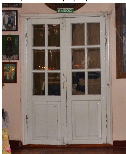
Фрагмент интерьера четверика
