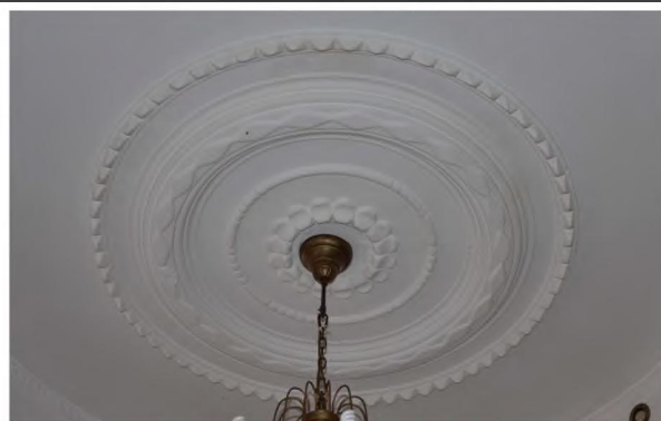
Фрагмент интерьера 1-го этажа.
