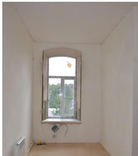
Фрагмент интерьера 2-го этажа.
