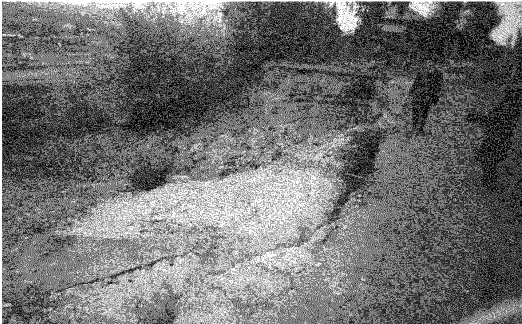
Рис.8. Оползень в г.Барнаул. Отголосок Чуйского землетрясения 2003 года. Фото Т.Ю. Симоновой.
