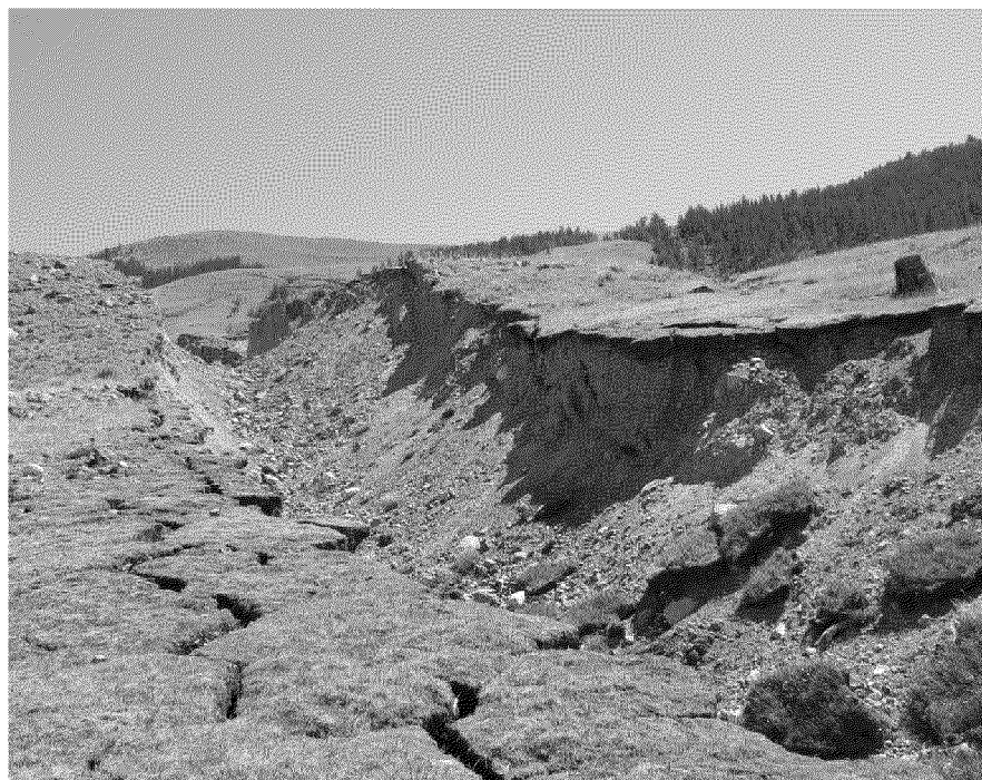
Рис.2. Сейсмотектонический ров, возникший в результате землетрясения. Фото И.С. Новикова.
