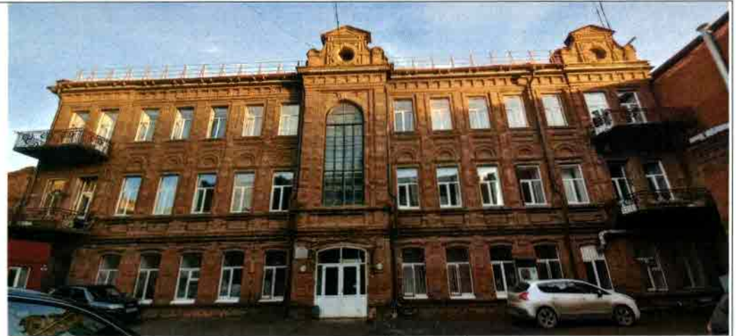
Северо-западный фасад объекта
