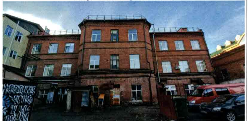
Юго-восточный фасад объекта (дворовой фасад)
